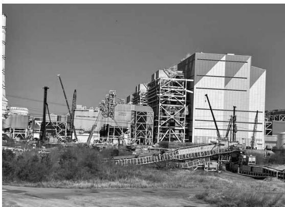
▲JERAのアンモニアタンク工事
