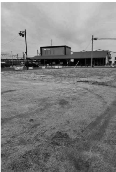
▲着々と進む碧南駅前広場
