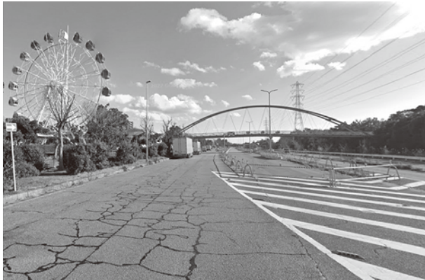
▲4車線化事業が進む国道247号
