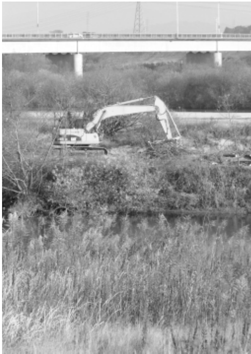
▲矢作川中洲の土砂と樹木撤去
