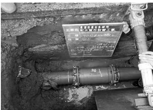
▲配水管の耐震化布設替え工事の状況
