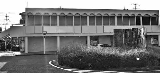
▲碧南中央駅のテナントの状況
