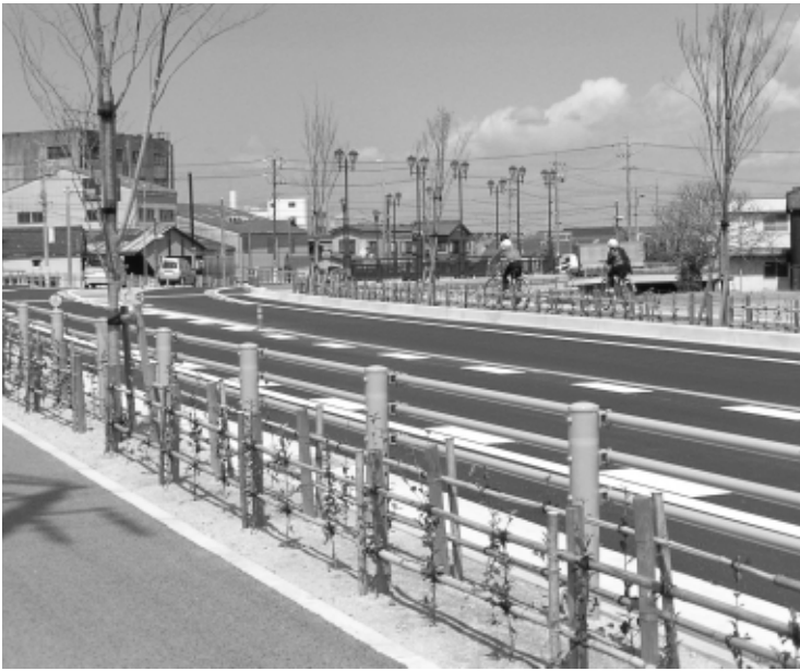
▲3月に開通した都市計画道路碧南高浜線と塩とり橋
